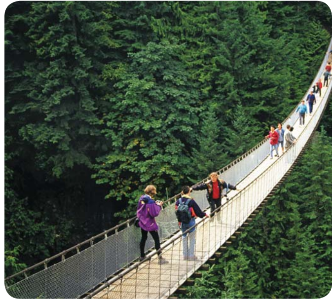
Figure 4 Les câbles principaux d'un pont suspendu, comme ceux du pont suspendu de Capilano, en Colombie-Britannique, sont soumis à l'action de la tension.
