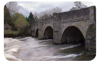
Figure 9 L'eau grossie par les pluies frappant un pont est un exemple de charge dynamique.
